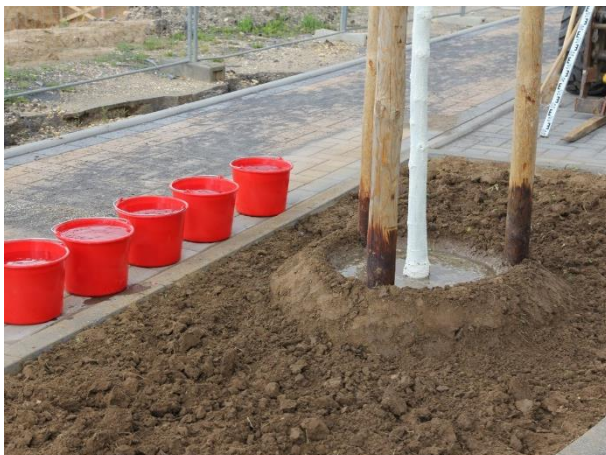
Abbildung 31: Das Anwässern sollte nach oben genannter Vorgabe in mehreren Gaben erfolgen, so dass sämtliches Wasser vom Ballen über den Bereich innerhalb des Gießrandes aufgenommen werden kann, Bildquelle: LKSH
